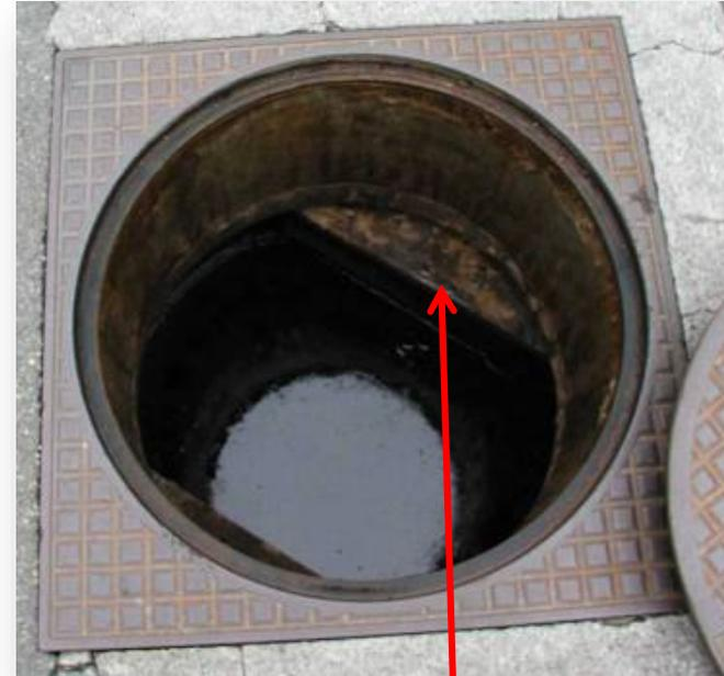
Prélèvement d'échantillon impossible sur ce puits, car la sortie est fermée (paroi plongeante fermée).
