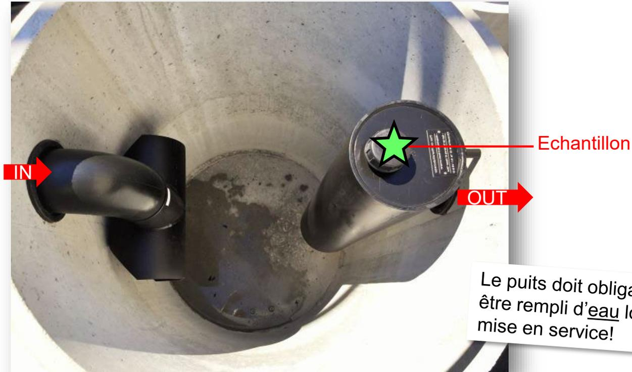
Le puits doit obligatoirement être rempli d'eau lors de la mise en service!
