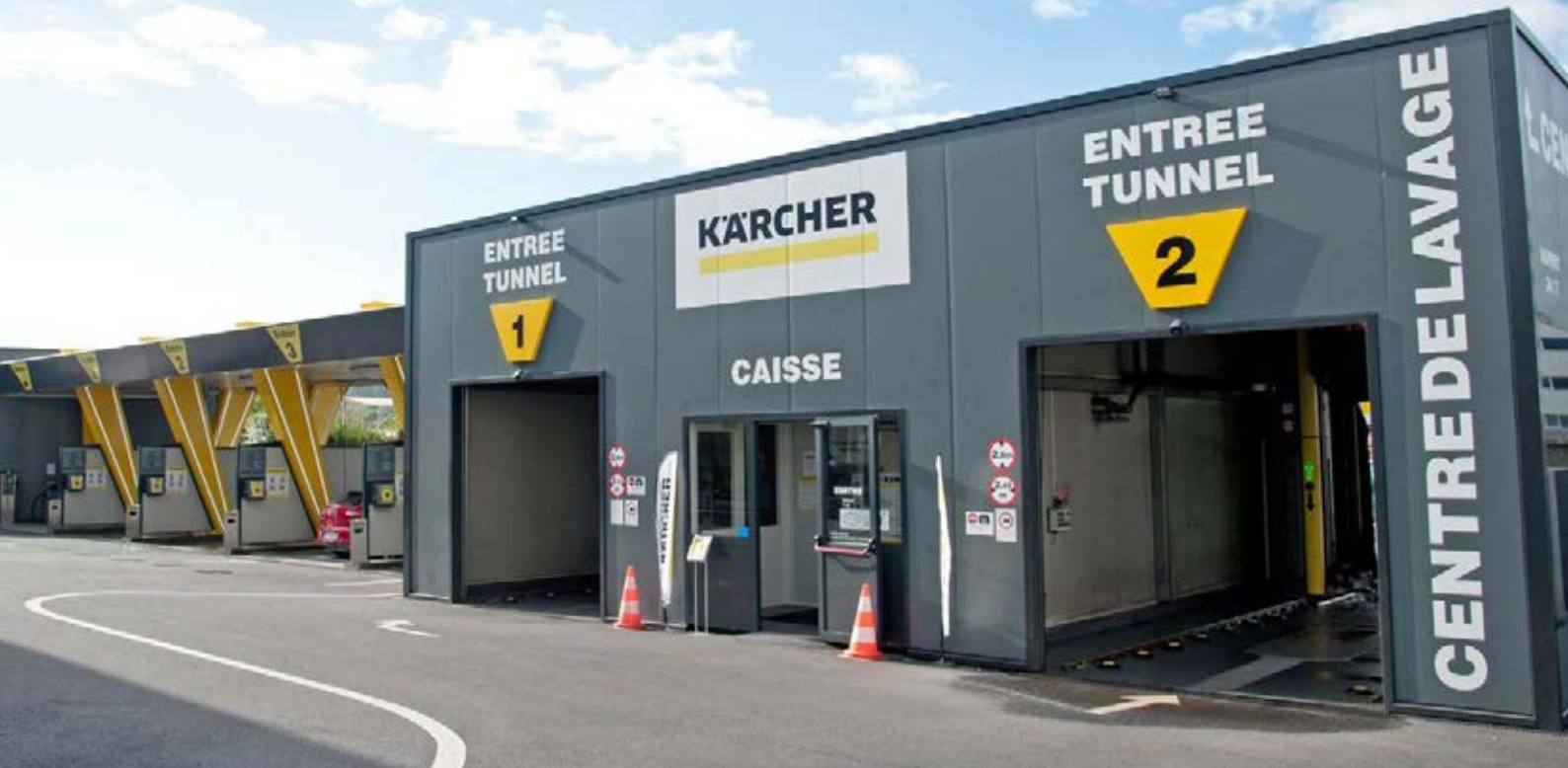
Entre les deux portails de lavage : la caisse et toute la technologie nécessaire au centre
