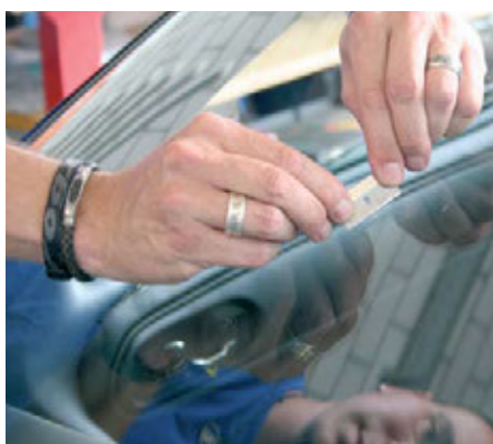
Bild 5. Überschüssiges Harz wird mit einer Klinge vorsichtig abgezogen.
