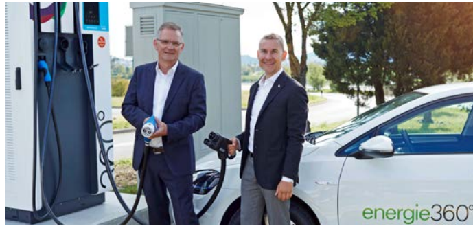
Armin Schnellmann, Avia Autobahn-Service Forrenberg AG (à gauche) et Rainer Schöne, Energie 360°, sont ravis de la nouvelle station-service électrique.
