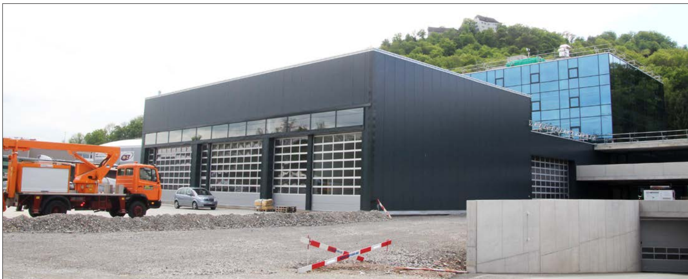
Le nouvel atelier pour poids lourds de Hans Meyer AG vu de l'extérieur. Derrière, le nouveau bâtiment des bureaux. Au fond, sur la colline, le château de Brunegg.
