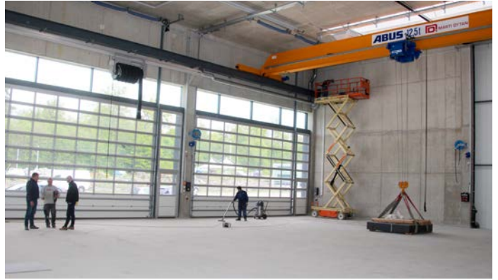
Trouver une solution ensemble: N. Shabani et E. Luginbühl discutent avec l'électricien.
