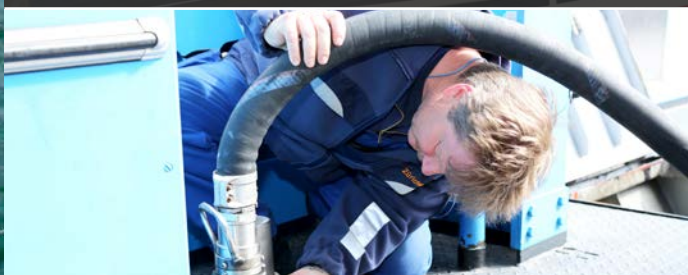
Adrian Hauser checkt den Einfüllstutzen auf der «Horgen».
