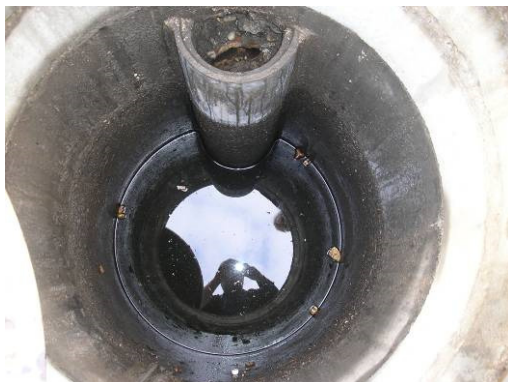
undichter Schacht
