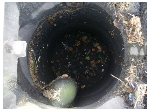
undichter Einlaufschacht
